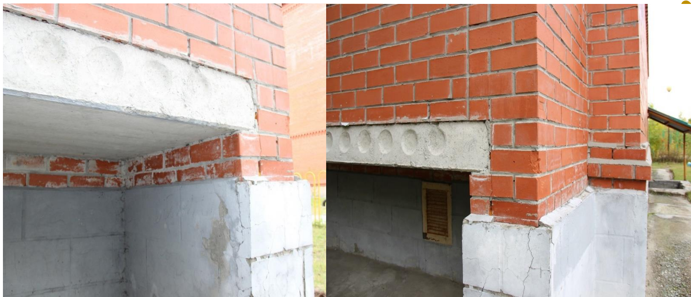
Фото №31. Ложковая кладка под плитой и по всему ряду вид слева и справа.
