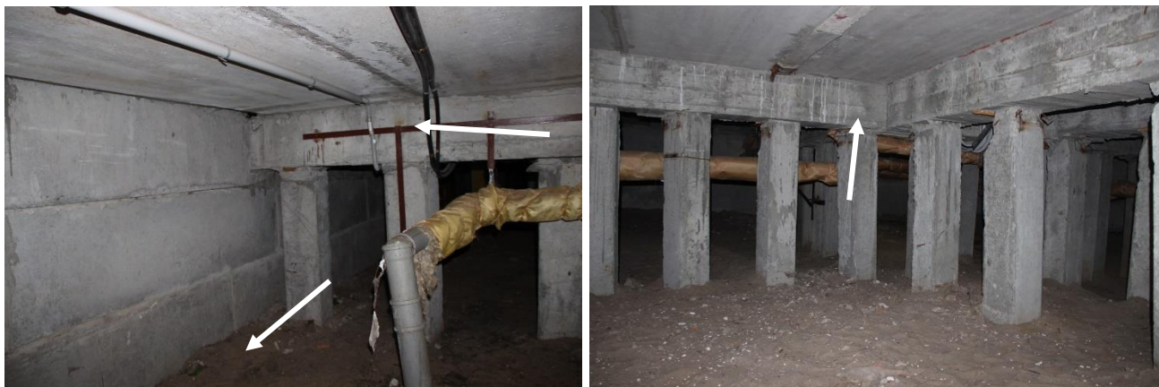
Фото №6,7. Стрелками указан «верхний» и «нижний» ростверки.
