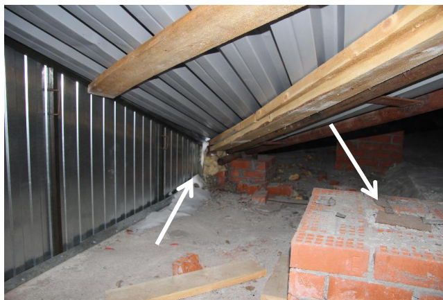
Фото №23,24 .Временные подпорки и снег ( из результатов обследования в феврале 2022г.)
