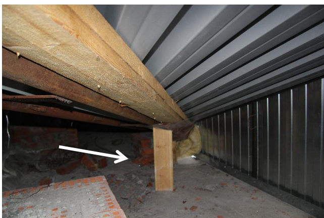
Фото №23,24 .Временные подпорки и снег ( из результатов обследования в феврале 2022г.)
