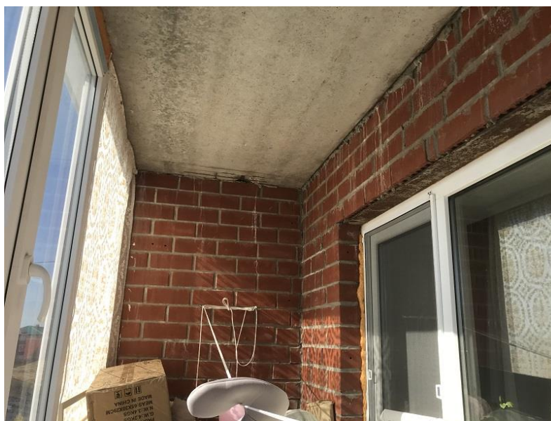
Фото №44. Правая сторона лоджии кв. №27 дома №24/1 по ул. Магистральная аналогичной серии. Сплошные ряды ложковой кладки без силовых и осадочных трещин.
