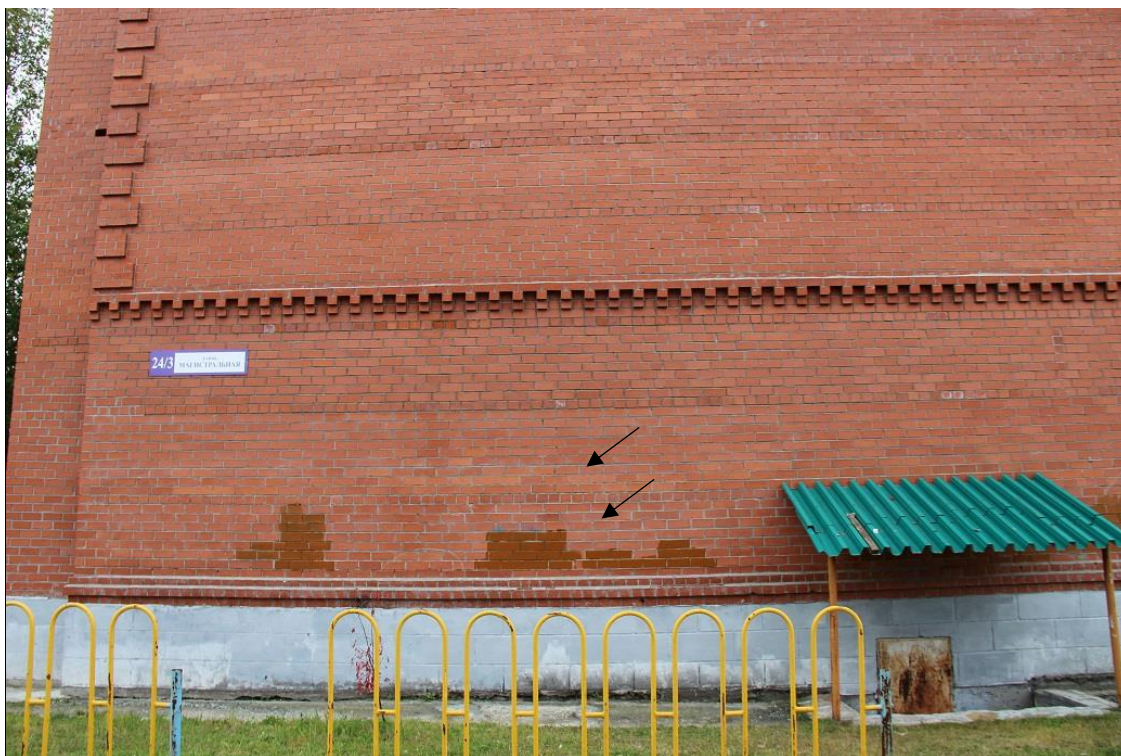
Фото №17. Магистральная 24/3 с раскрытием до 2 мм. Трещина через 9 рядов по швам и с разрывом камня.
